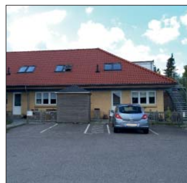
Bankbygningen er i dag ombygget til boliger
